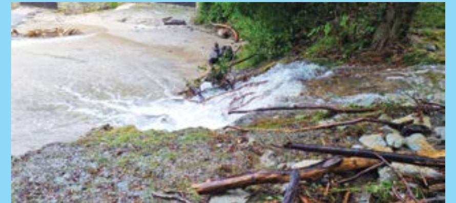
Tok vody po cestnej komunikácii na Potočnej ulici pripomínal miestami riečište.
